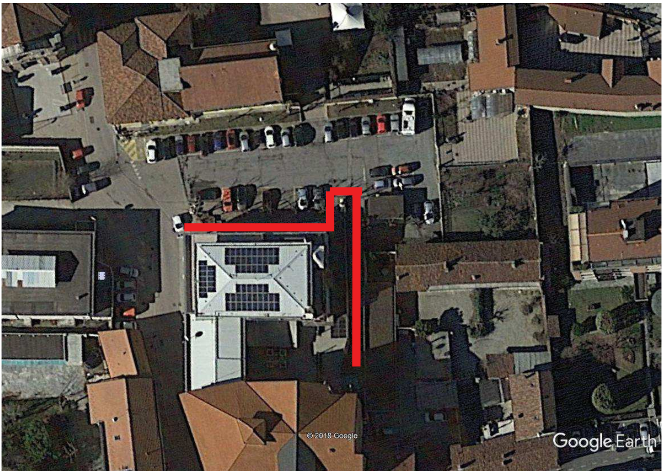
d) Rampa carraia autorimessa comunale – Piazza Dalla Chiesa n. 3
